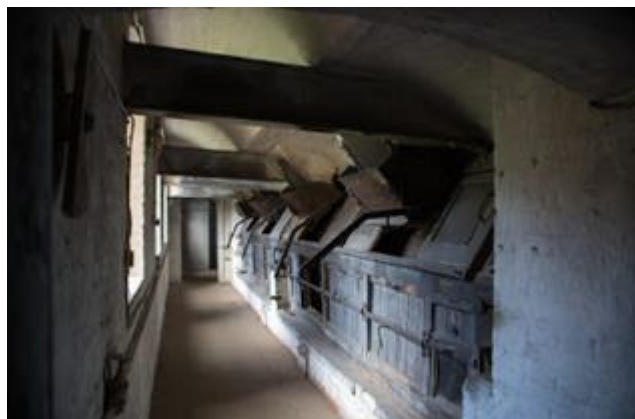
Zdjęcie 5 – Wyłuszcarnia nasion wewnątrz
