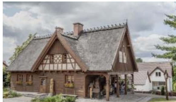
Zdjęcie 9 – budynek Wiejskiego Domu Kultury w Swornegaciach
