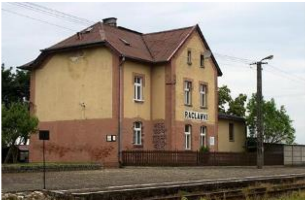
Zdjęcie 20 – Raclawki, budynek dworca kolejowego
