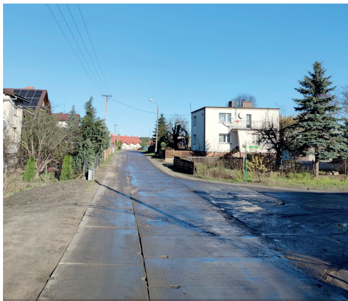
Remont nawierzchni w Karolewie
