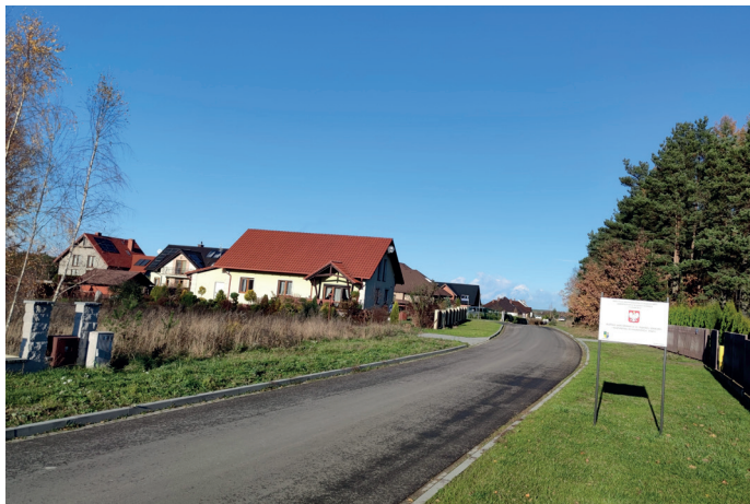
Wybudowany odcinek ul. Dębowej w Chojniczках
