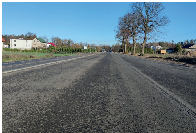
Nowa nawierzchnia z mieszanki mineralno - asfaltowych
