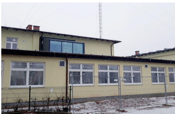
Dobudowana część szkoły
