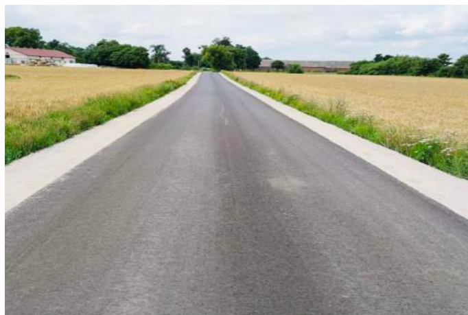
Nakładki asfaltowe na istn. podbudowie w m. Kruszka
