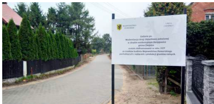
Droga dojazdowa w Doręgowicach
