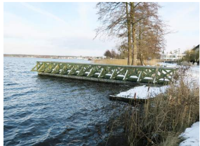
Wylot kanalizacji deszczowej WB2 w miejscowości Charzkowy ul. Jeziorna
