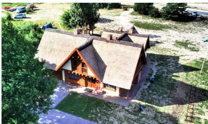
Budynek stacji wodnej
